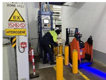
Site frigorifique STEF à Athis Mons, France
